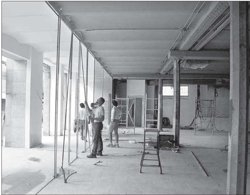
Imagen tomada ayer de la situación actual de los trabajos en el edificio de Santa Columba
