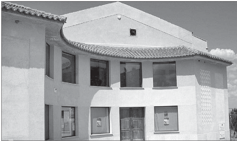
Edificio que alberga el Centro de Interpretación del Folklore de San Pedro de Gaillos
