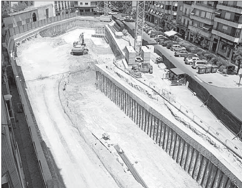
Las obras del aparcamiento de José Zorrilla finalizarán en junio de 2005
