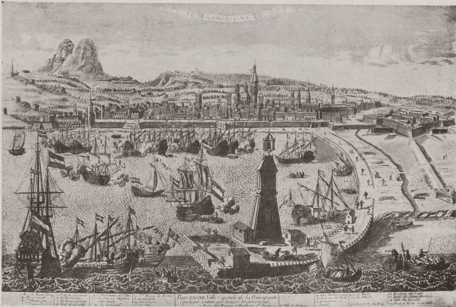
Vista de Barcelona desde el mar con la farola en primer término. A la derecha, la Ciudadela; al fondo, con relieve muy exagerado, la montaña de Montserrat. Grabado de mediados del siglo XVIII. (Archivo Histórico de la ciudad)
