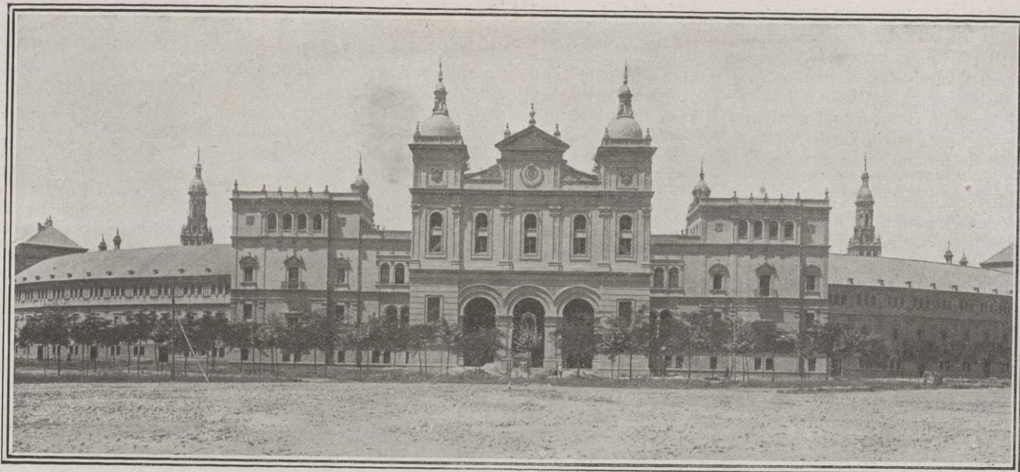
Detalle de las obras de la fachada posterior del edificio central de la Plaza de España
