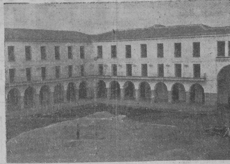
Un aspecto de la Plaza Mayor, de Peñaranda de Bracamonte, durante su reconstrucción. Dichas obras han finalizado actualmente y el Patronato de Reconstrucción ha entregado al Ayuntamiento de dicha ciudad once bloques de viviendas, junto con la Plaza, que muestra la fotografía. — (Foto Cifra)
