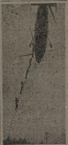
Pruebas de salvamento de supuestos naufragos efectuadas por un helicóptero de la Marina norteamericana. El aparato descehó hasta una altura de cincuenta pies sobre el lugar donde se hallaban los supuestos naufragos y, arrojando una escala de cuerdas resistente, éstos se encaramaron al helicóptero sin el menor daño en pocos segundos. (Foto Ortiz).
