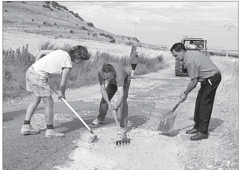
Los vecinos han optado por acometer ellos mismos los trabajos de acondicionamiento
