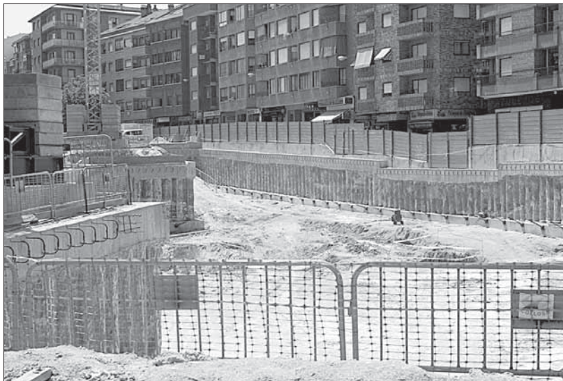
La construcción del aparcamiento avanza a buen ritmo y dentro de los plazos previstos
