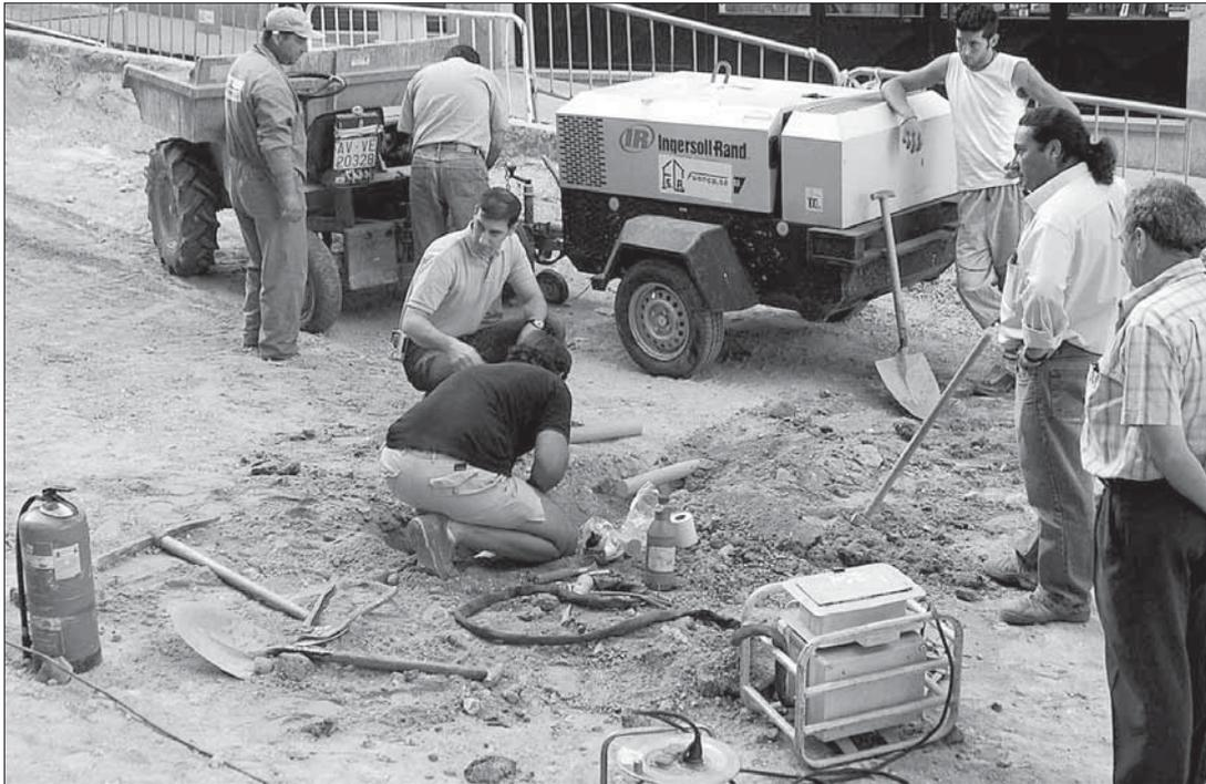
El equipo que se desplazó a la calle Los Coches examina la zona en la que la máquina perforó la tubería, para proceder a su arreglo. KAMARENO
