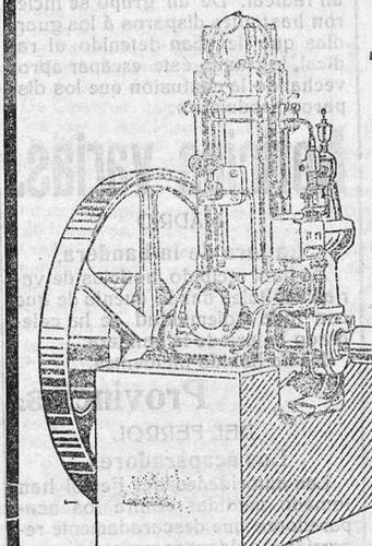
Motor para aceites pesados sin válvulas, sin magno to, adecuados para trilladoras.
