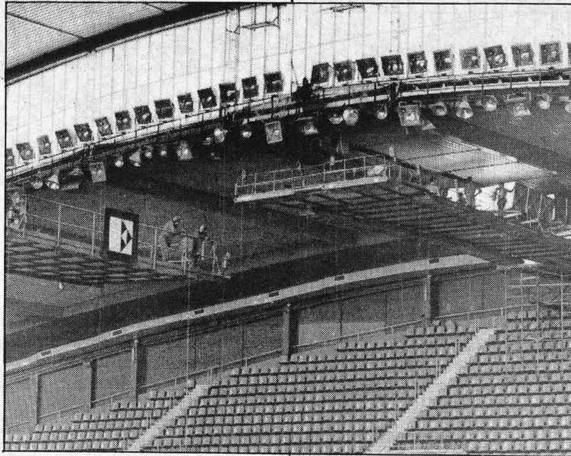
Las obras de ventilación se han iniciado recientemente. Gracias a ellas se conseguirán doce grados menos en el interior del Palacio.
