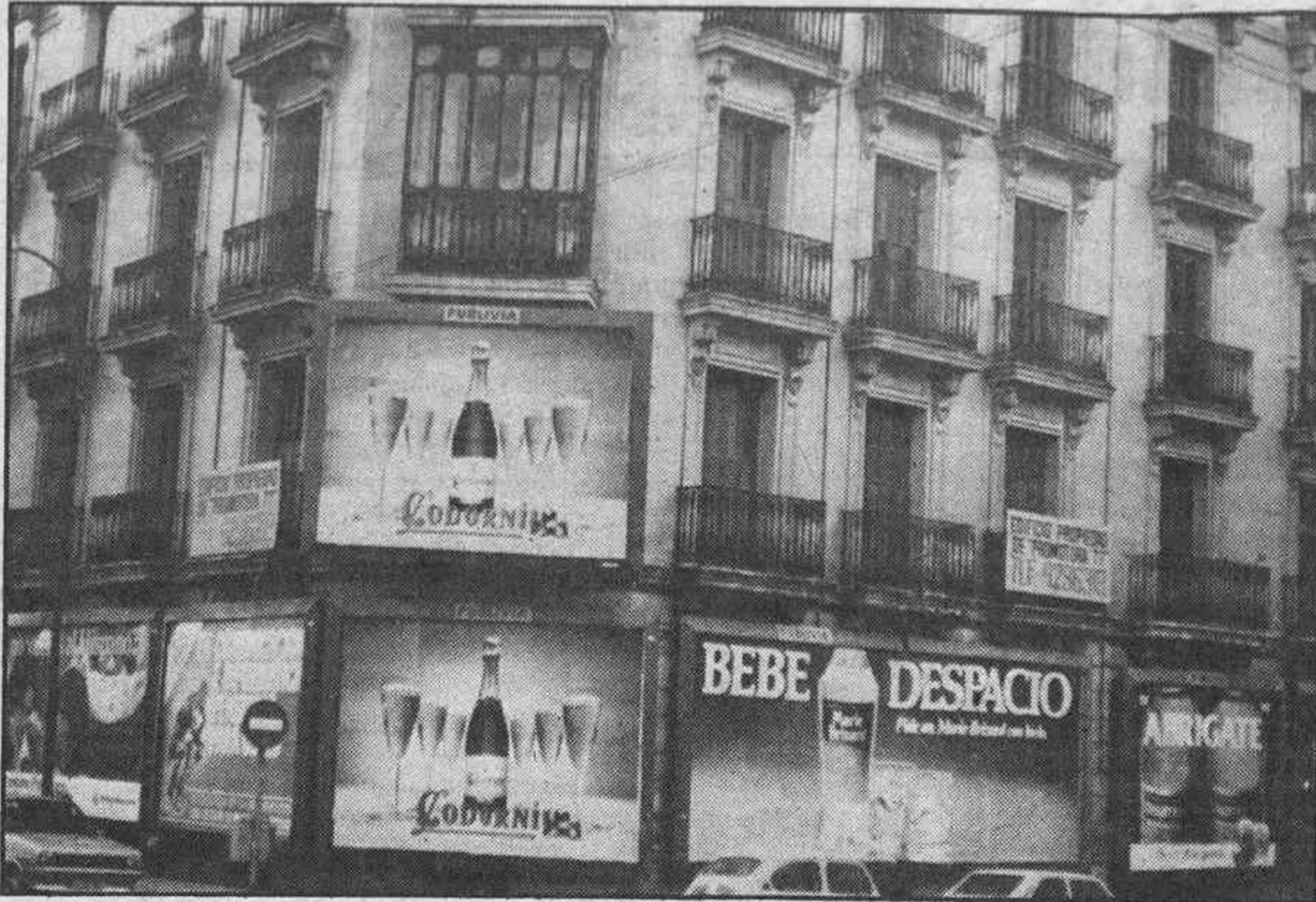
Edificios vacíos, tiendas abandonadas: zona maldita por el atentado del 20-N de 1973.
