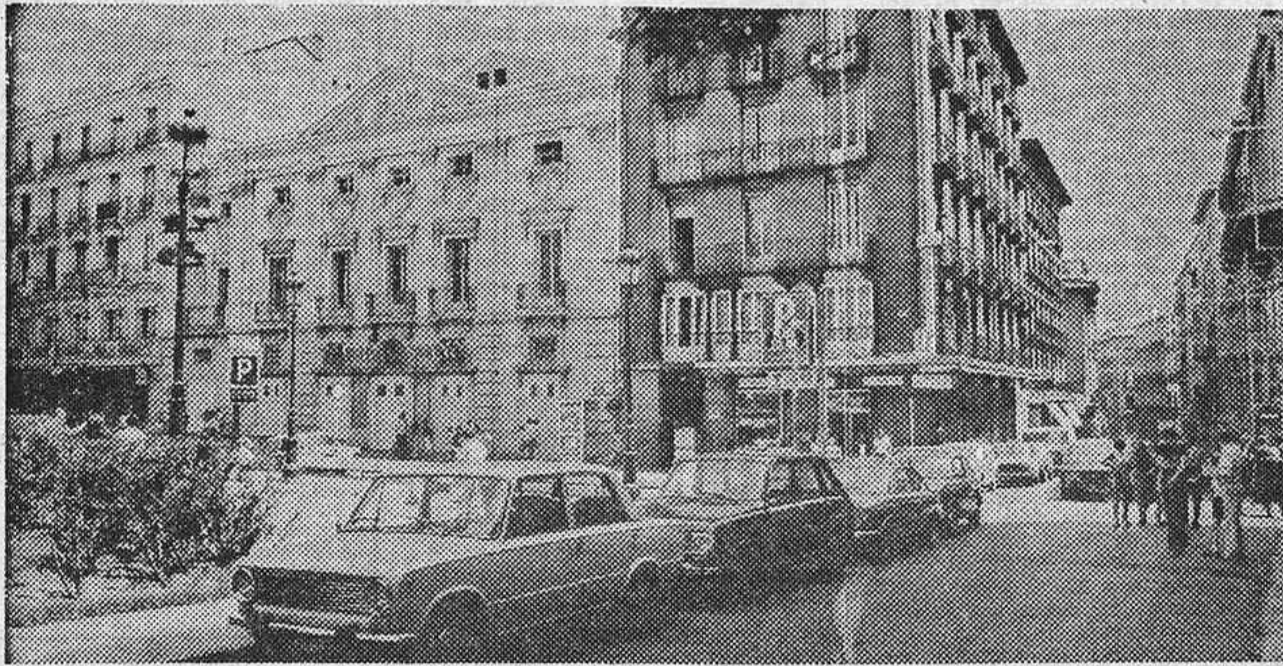
Las feos casas 23 y 27 de la calle del Príncipe, esquina a las de la Visitación y Prado, respectivamente, aprisionan la equilibrada fachada del teatro Español. La desaparición de aquéllas es la gran aspiración municipal para agrandar y embellecer el coliseo. (Torremocha.)
