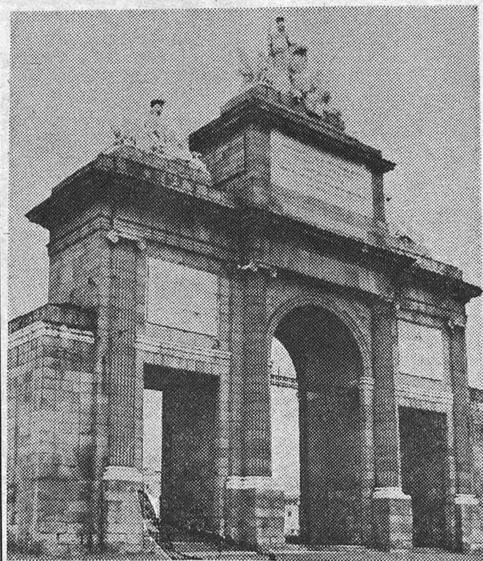
La Comisión municipal de Gobierno tiene en proyecto, si no ya aprobado, entre otras obras y asuntos, el lavado y limpieza del monumento histórico-artístico de la Puerta de Toledo, cuyo presupuesto para este aseo asciende a dos millones de pesetas. Estos trabajos serán contratados mediante concurso-subasta, dadas las características especiales de la obra. (Foto Torremocha.)
