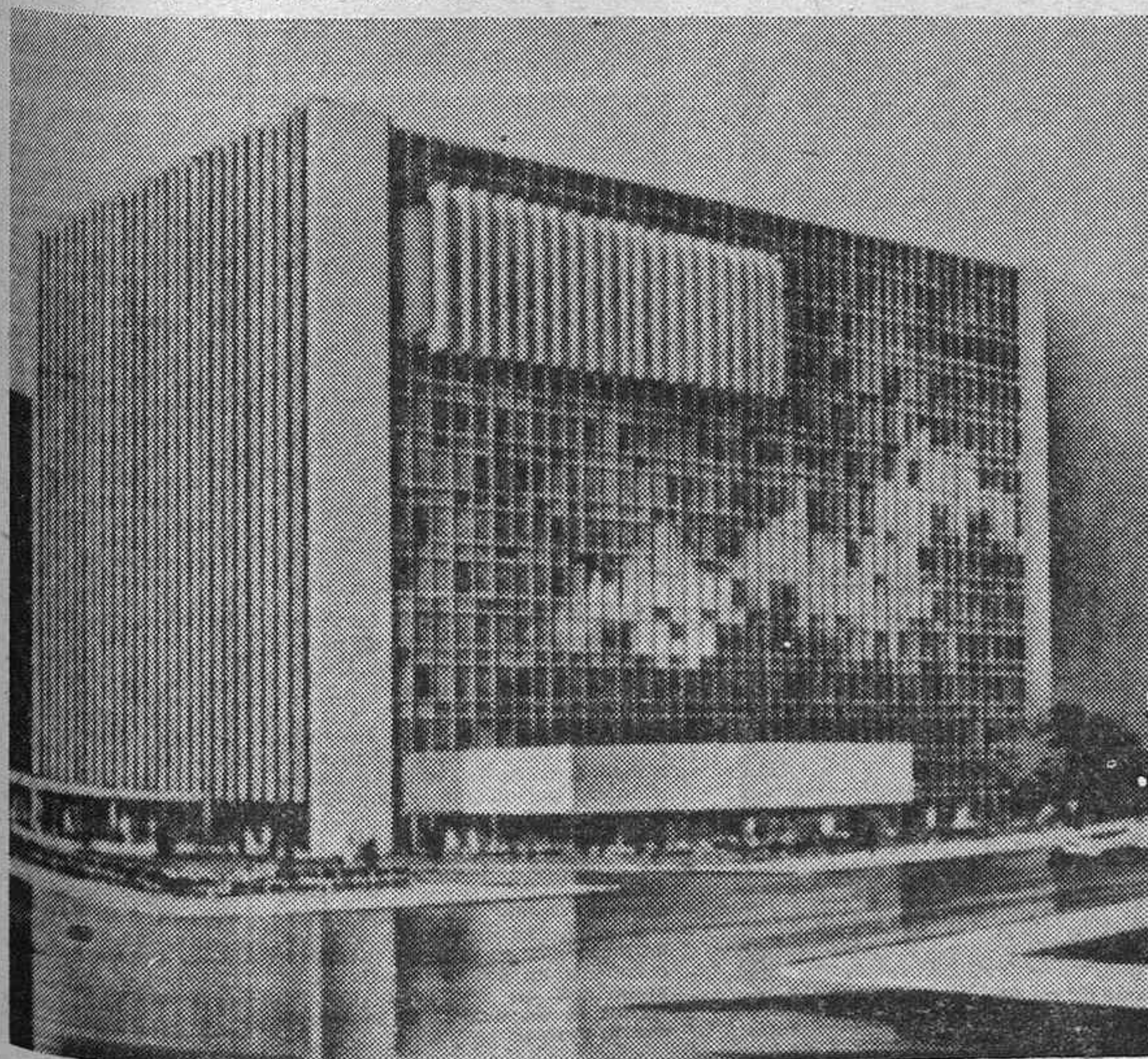
Perspectiva del nuevo edificio social de CAMPSA, en construcción avanzada, en Madrid
