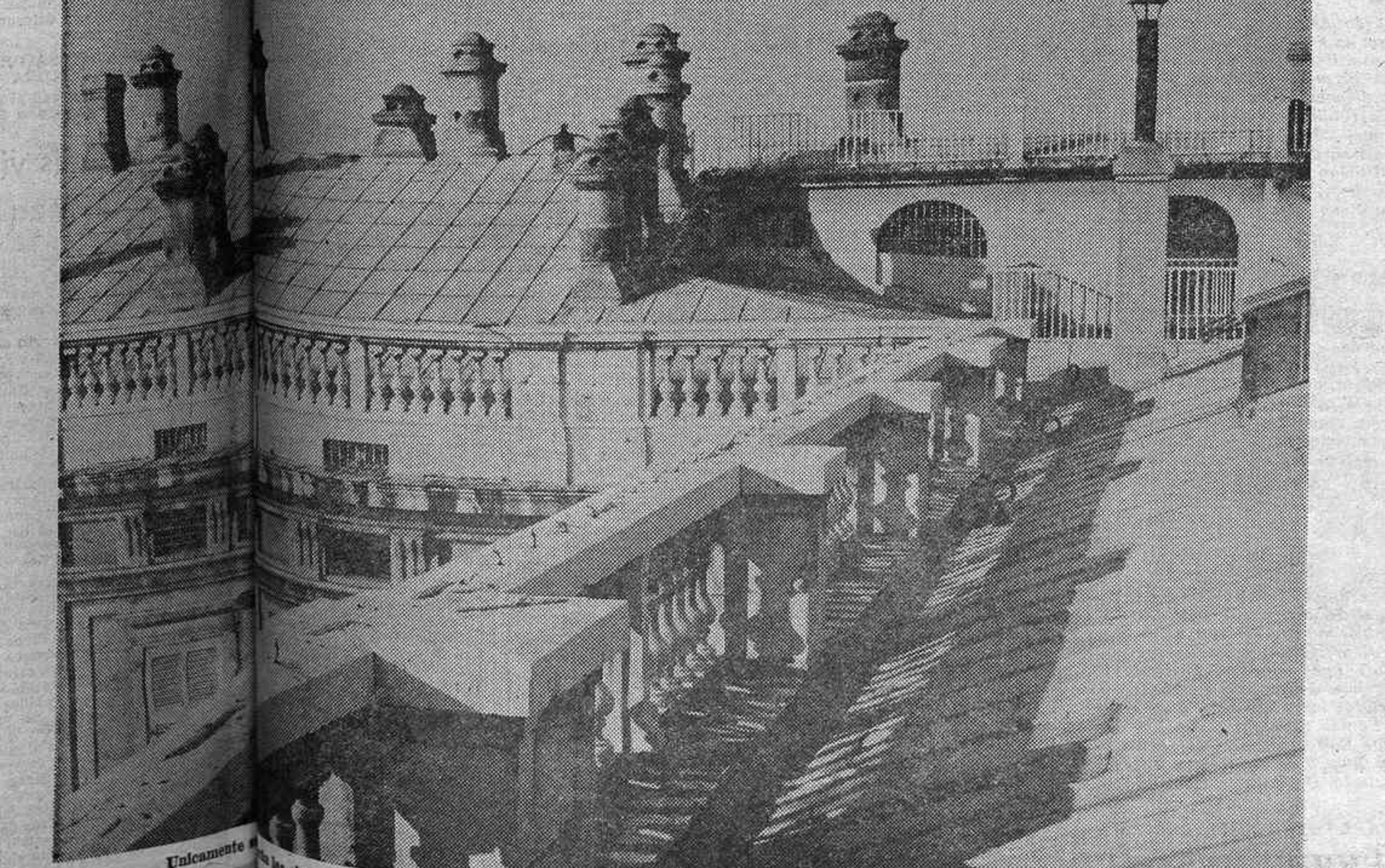
Unicamente en las chimeneas que pertenecen al proyecto original, que están hechas de granito labrado. (Foto Torremocha.)
