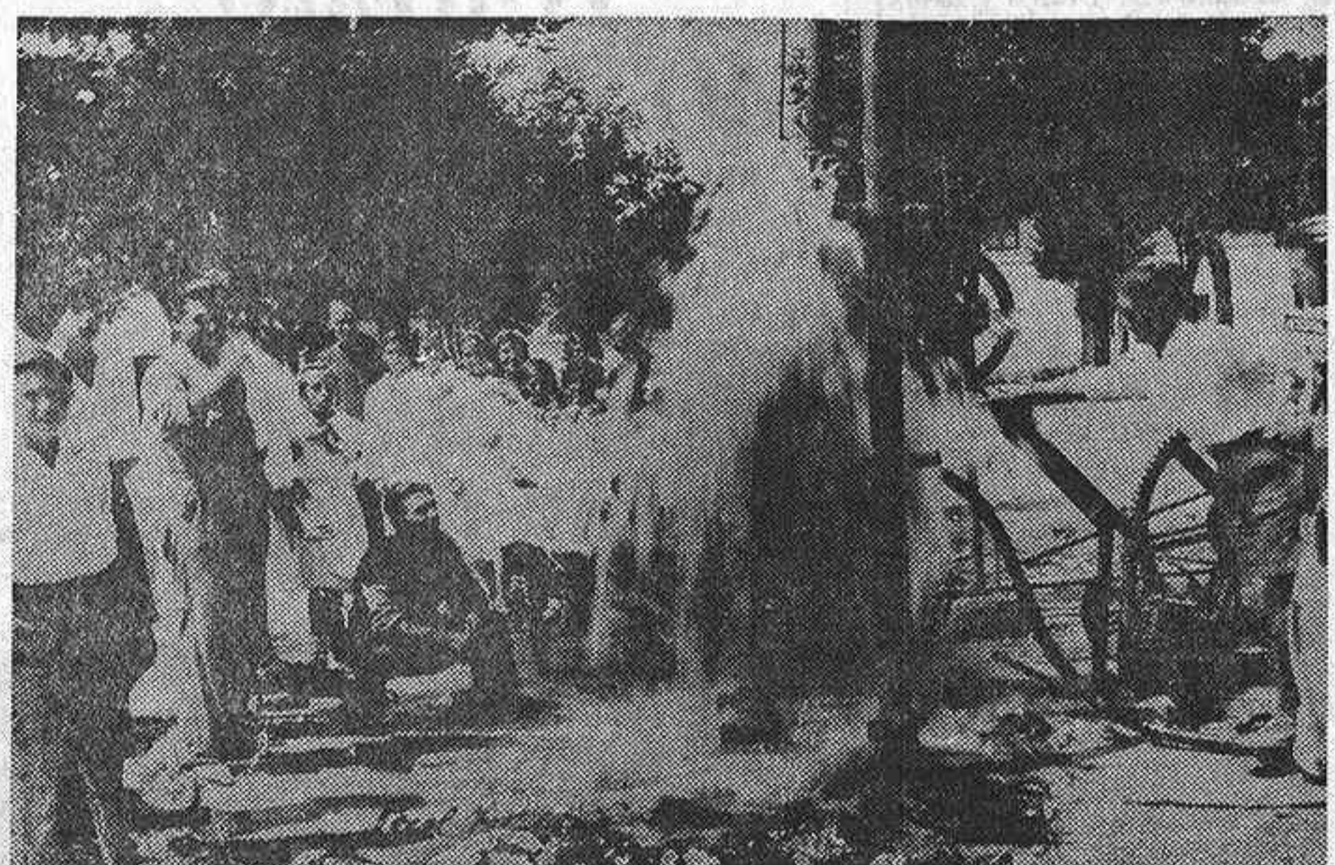
En el Orfanato de El Pardo, en el año 1921, se abrió un pozo artesiano, de 200 metros de profundidad, que proporcionaba un caudal de 420 litros por minuto. (Foto Torremocha.)
