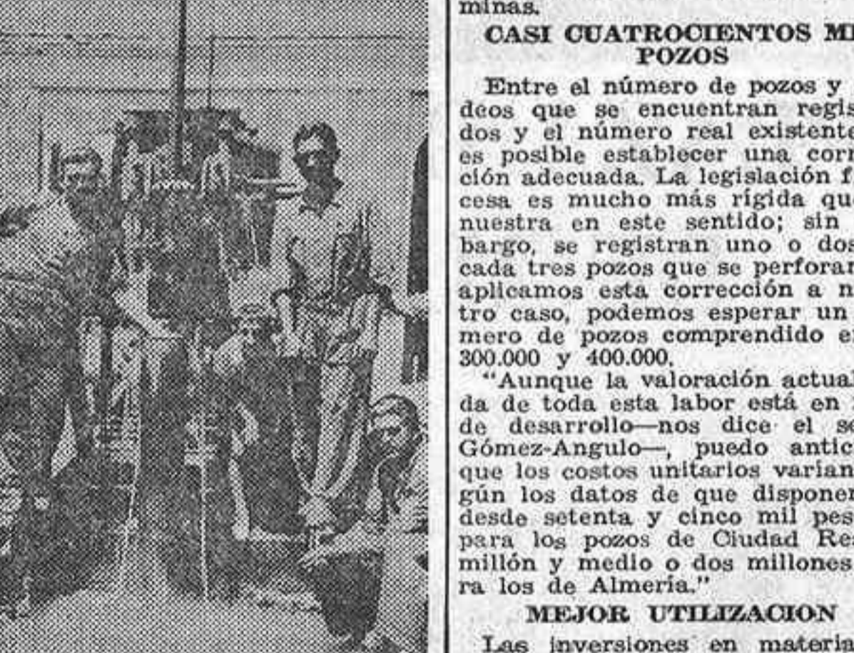
En la Casa del Infante, también en El Pardo, se hizo otro pozo artesiano de 115 metros de profundidad, que aportaba un caudal de 300 litros por minuto. (Foto Torremocha.)
