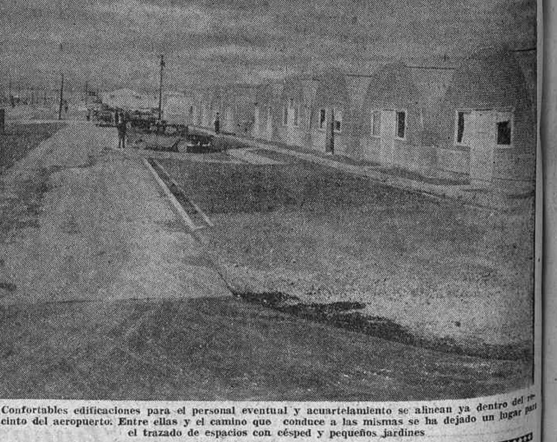
Confortables edificaciones para el personal eventual y acuartelamiento se alinean ya dentro del recinto del aeropuerto. Entre ellas y el camino que conduce a las mismas se ha dejado un lugar para el trazado de espacios con césped y pequeños jardines
