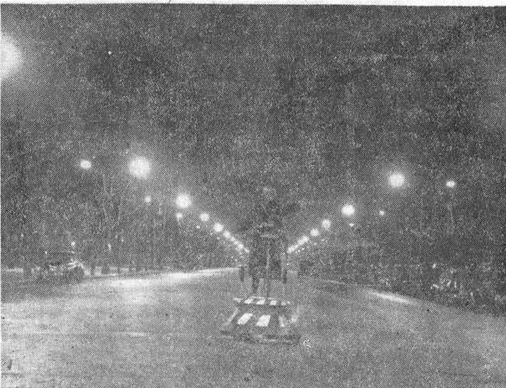
Esta bellísima perspectiva, que pudiera competir ventajosamente con la de una de las capitales europeas mejor iluminadas, está enfocada desde la calzada central de Recoletos a la hora de inaugurarse su modernísimo alumbrado. Una luz potente y distribuida con acierto manifiesto permite apreciar la avenida en todos sus detalles, desde los coches estacionados o en circulación hasta la actitud del guardia, que ha detenido el tráfico, para regular el paso de vehículos y peatones, en la confluencia de las calles de Bárbara de Braganza y Villanueva con el paseo. (Foto Portillo.)
