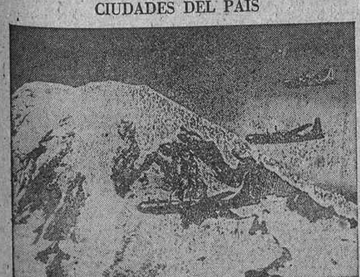
Estos aviones son los nuevos superbombarderos norteamericanos "B-50", modelo derivado y perfeccionado del "B-29", es decir, de la "superfortaleza volante". Los nuevos aviones, con un 69 por 100 más de potencia que el "B-29", tienen un radio de acción de 2.300 millas, y a una velocidad de 300, pueden transportar diez mil kilogramos de explosivos. (Foto CIFRA)
