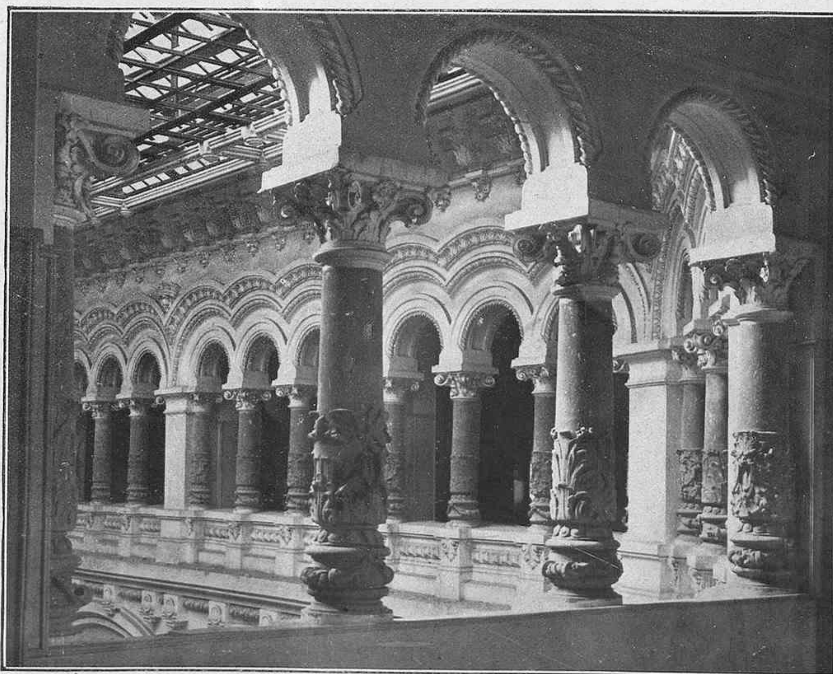
Vista parcial de una de las galerías del piso alto
