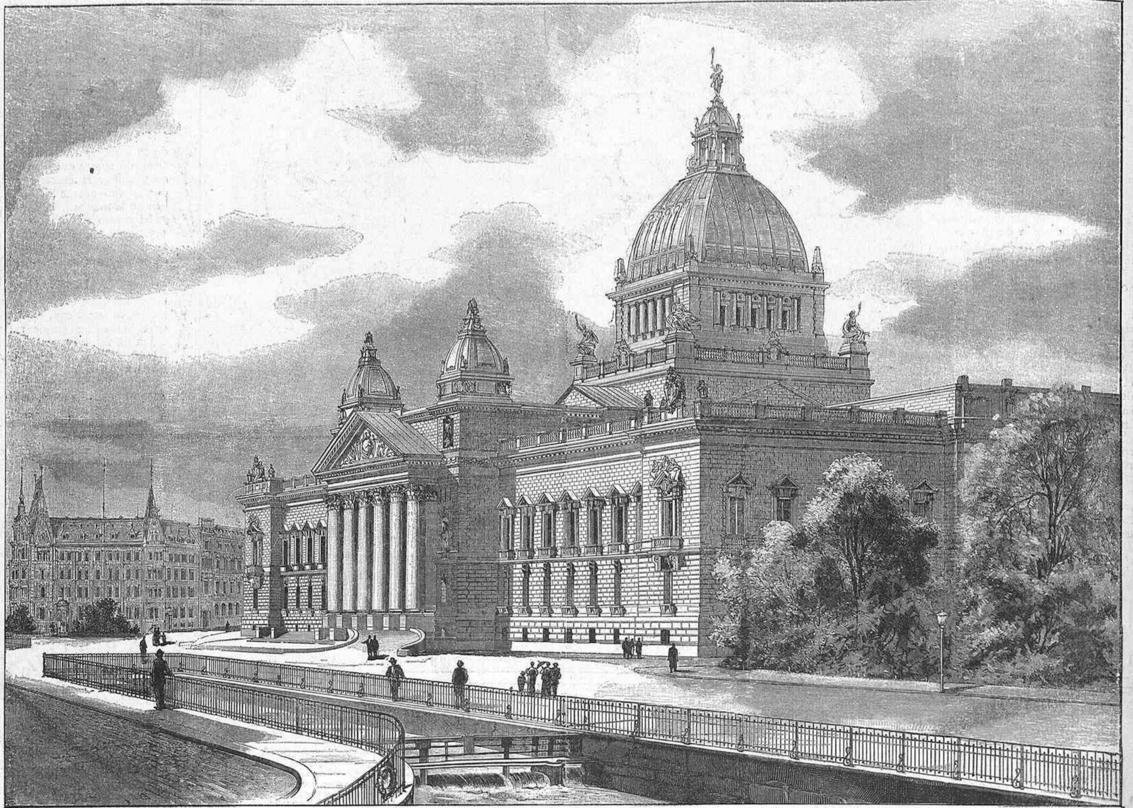
El nuevo Palacio de Justicia del imperio alemán, recientemente inaugurado en Leipzig, obra del arquitecto Luis Hoffmann
