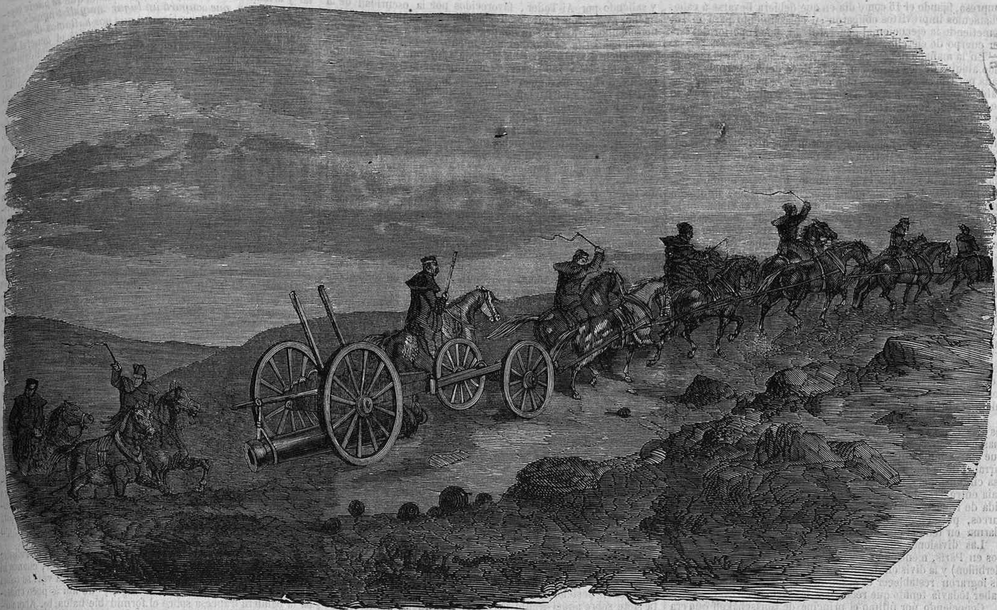
Trasporte de cañones lancasterianos á las baterías inglesas delante de Sebastopol.
