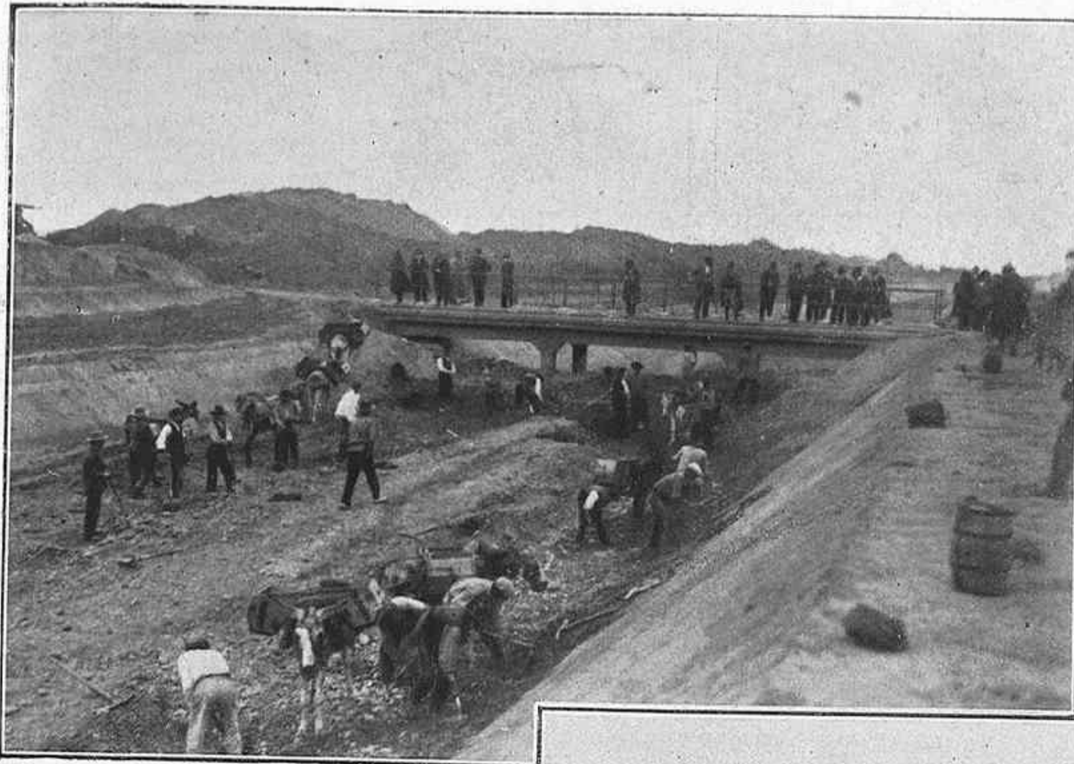
Trabajos en el canal y uno de los pasos de hormigón armado, de 8 metros de ancho
