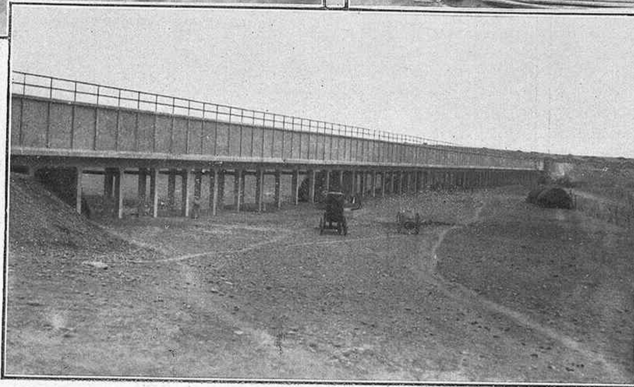
Acueducto de hormigón armado para el paso del arroyo de Alfanaque
