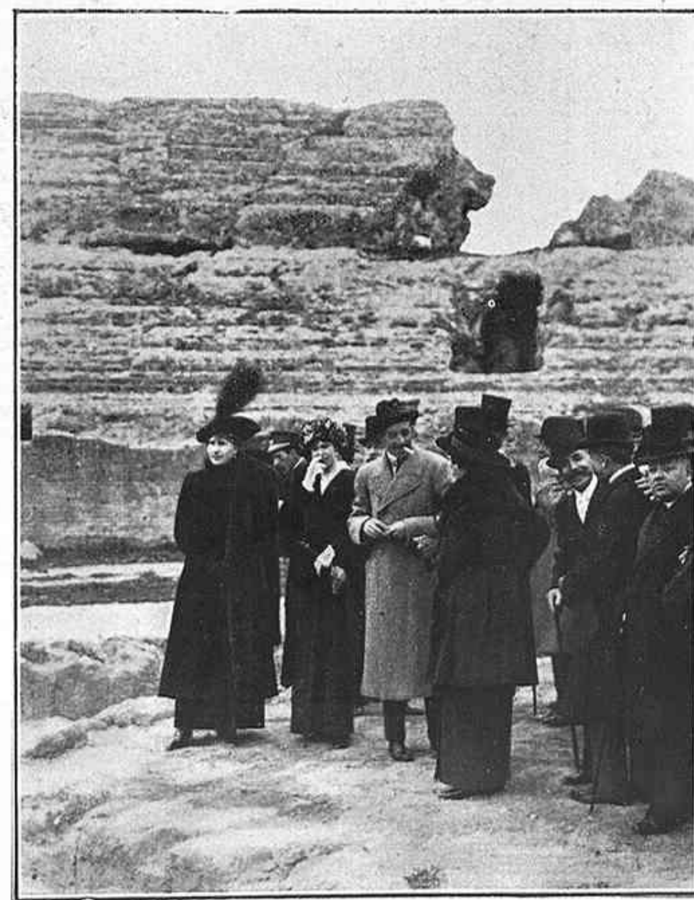
SS. MM. presenciando las excavaciones que se efectúan en el Circo Romano
