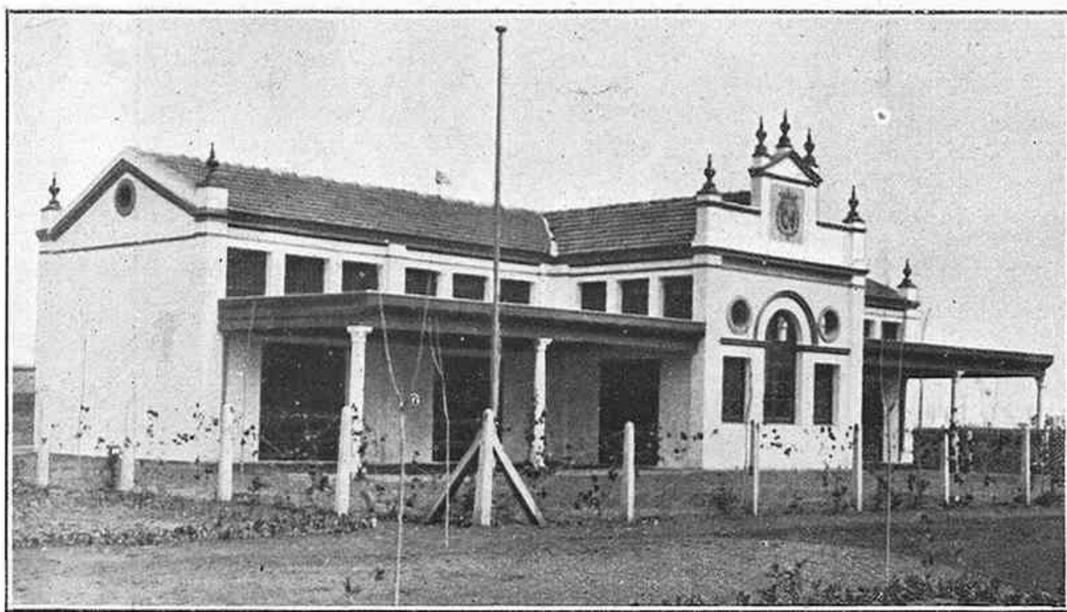
Edificio destinado a escuelas del barrio obrero
