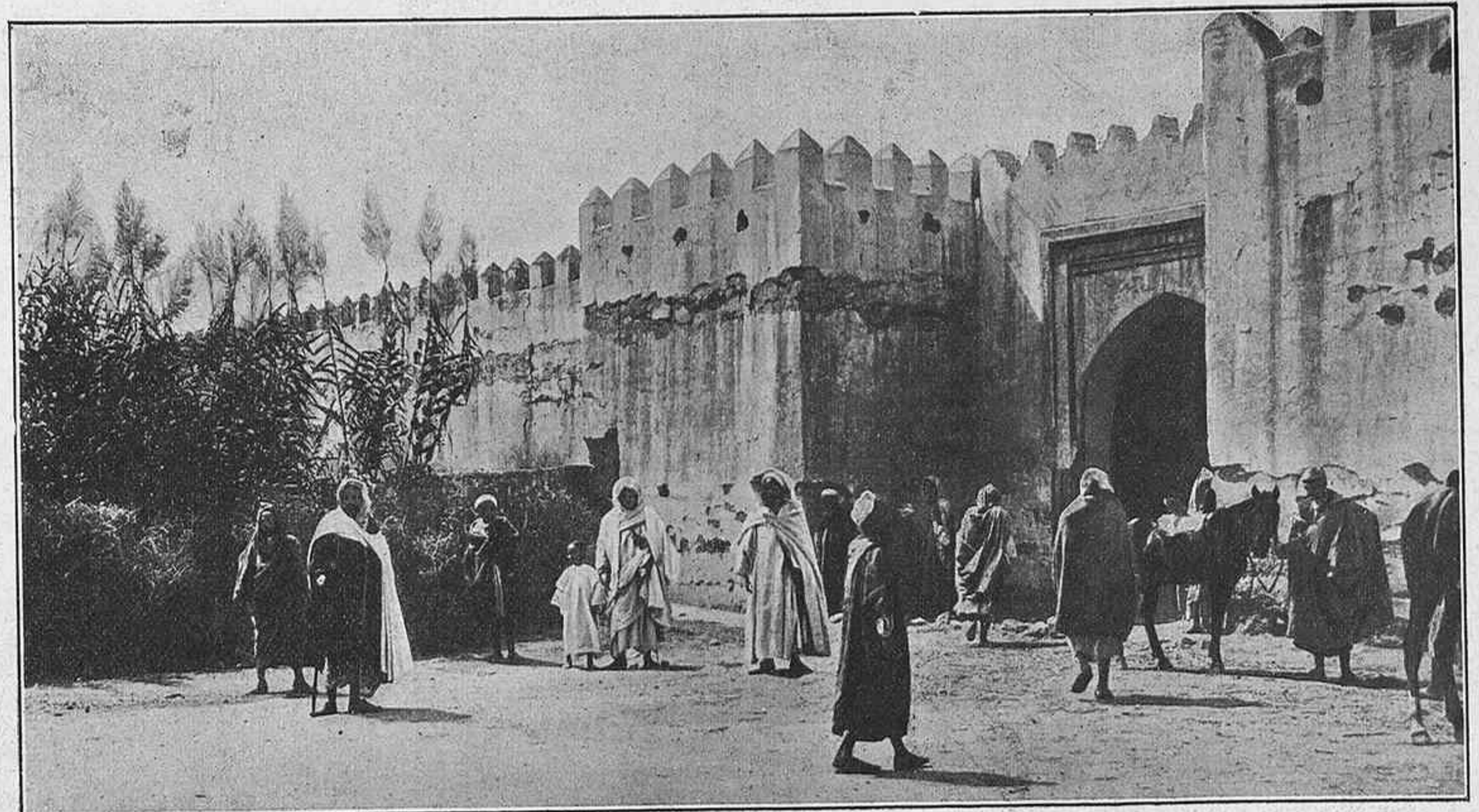
UNA DE LAS PRINCIPALES CALLES DE UXDA. (De fotografía comunicada por Photo-Nouvelles.)
