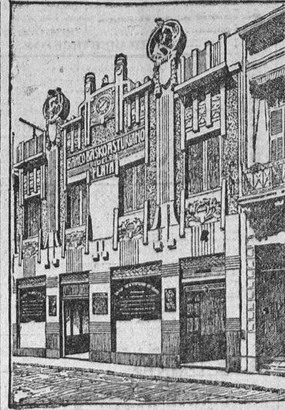
EDIFICIO DEL BANCO
