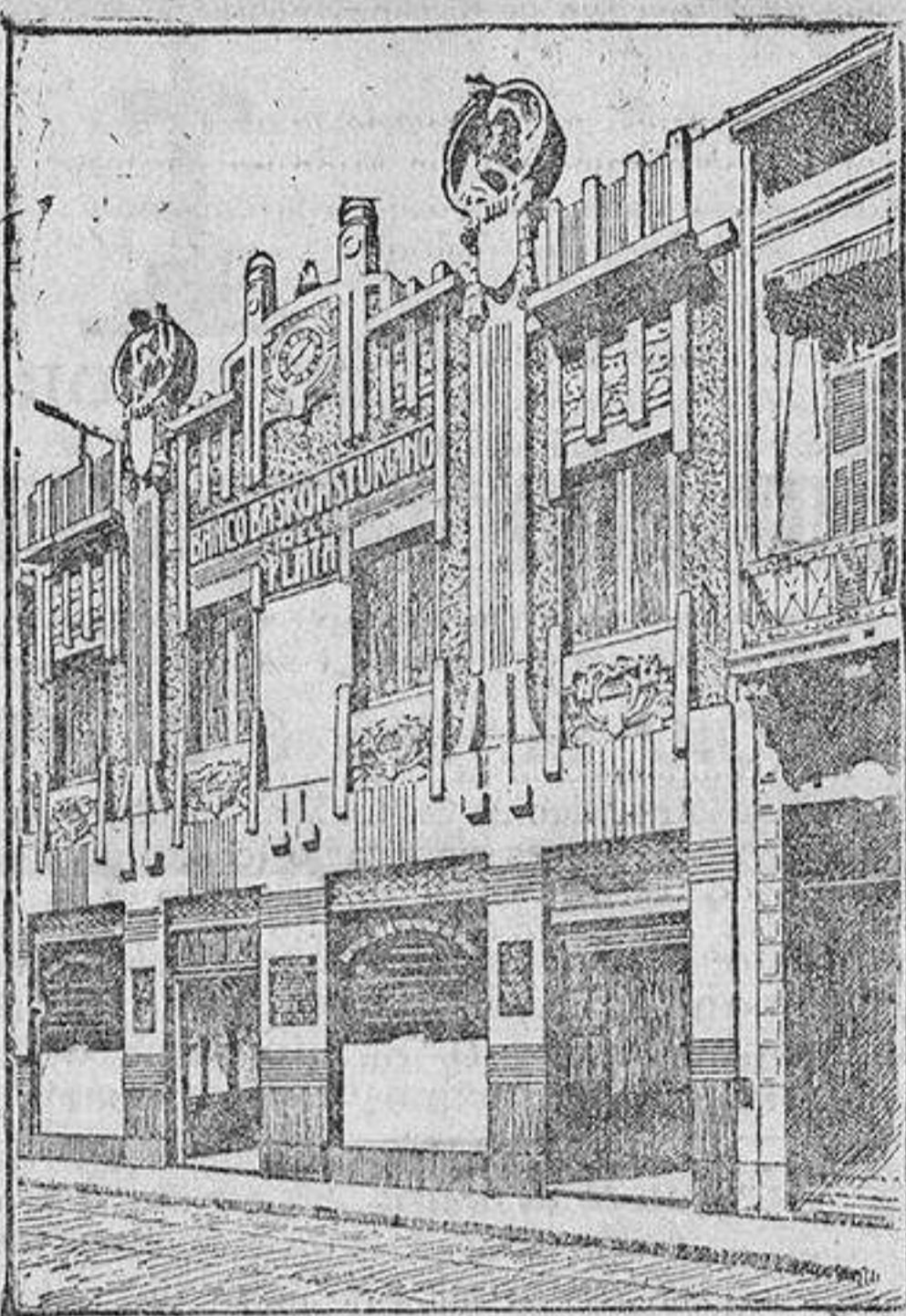
EDIFICIO DEL BANCO
