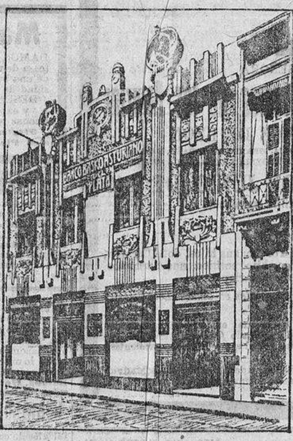
EDIFICIO DEL BANCO
