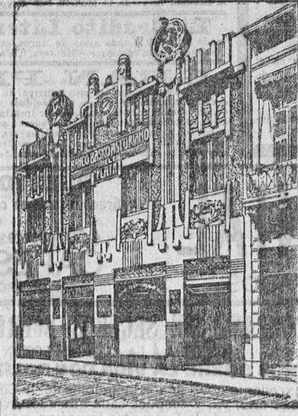
EDIFICIO DEL BANCO
