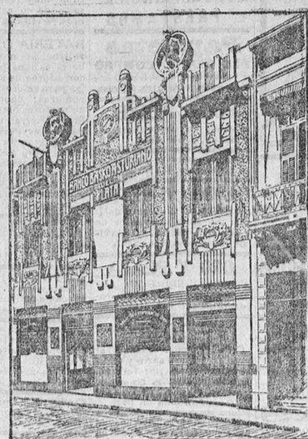
EDIFICIO DEL BANCO
