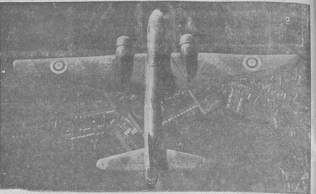
Avión de bombardeo inglés «Wickers Wellington». Tiene el fenomenal radio de acción de 5.200 kilómetros. Los motores son dos «Bristol Pegasus», con compresor que desarrolla 1.800 HP. en total.
