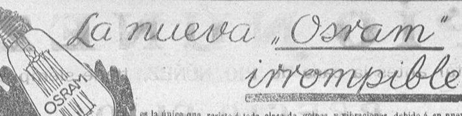
es la única que resiste á toda clase de gotpes y vibraciones, debido á su nuevo procedimiento en fabricarse con filamento de hilo estirado irrompible. Se pucde adontar la nueva lampara «OSRAM» en todos aquellos sitios donde antes no podian instalarse lamparas de filamento metalleo.
