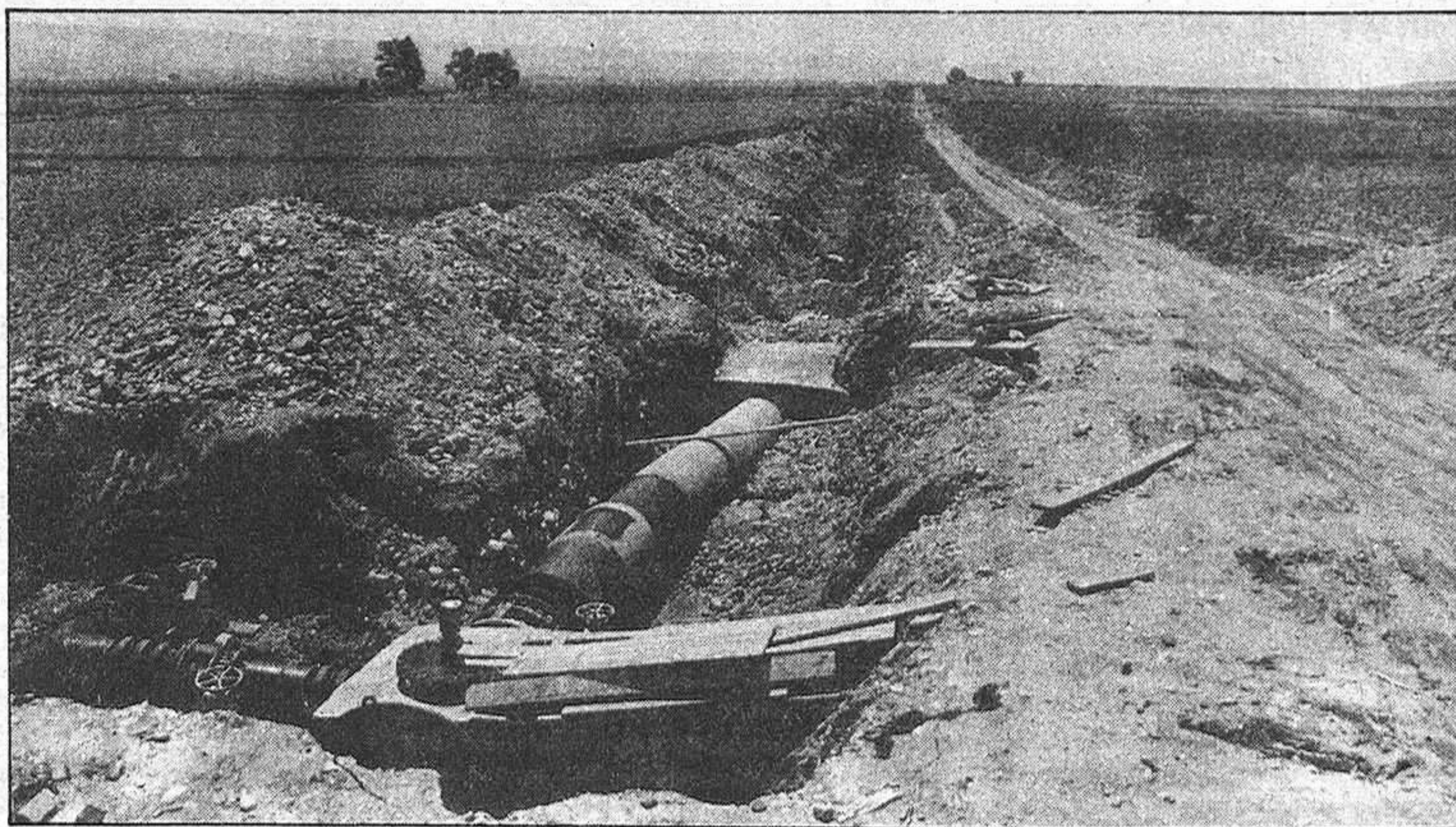
Obra de desdoblamiento del canal: Marchamalo-Alcalá de Henares.
