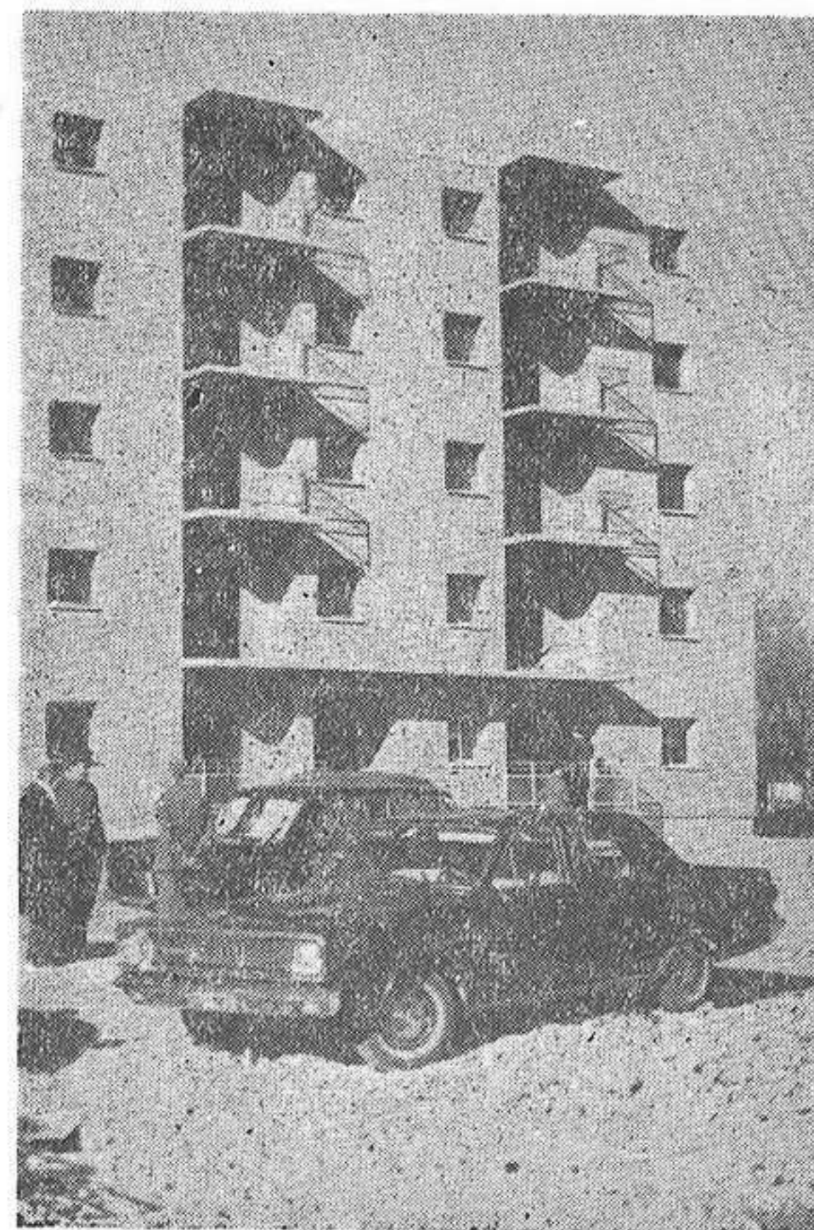
Vista parcial del bloque de cien viviendas, a punto de ser terminado. Ha sido construido en el tiempo récord de doce meses.
