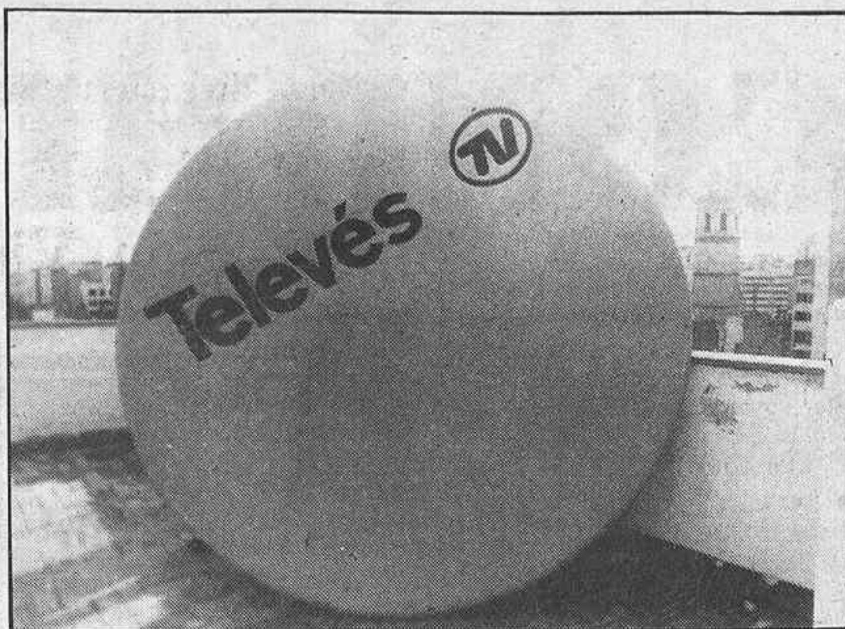
Instalación de una de las parabólicas
