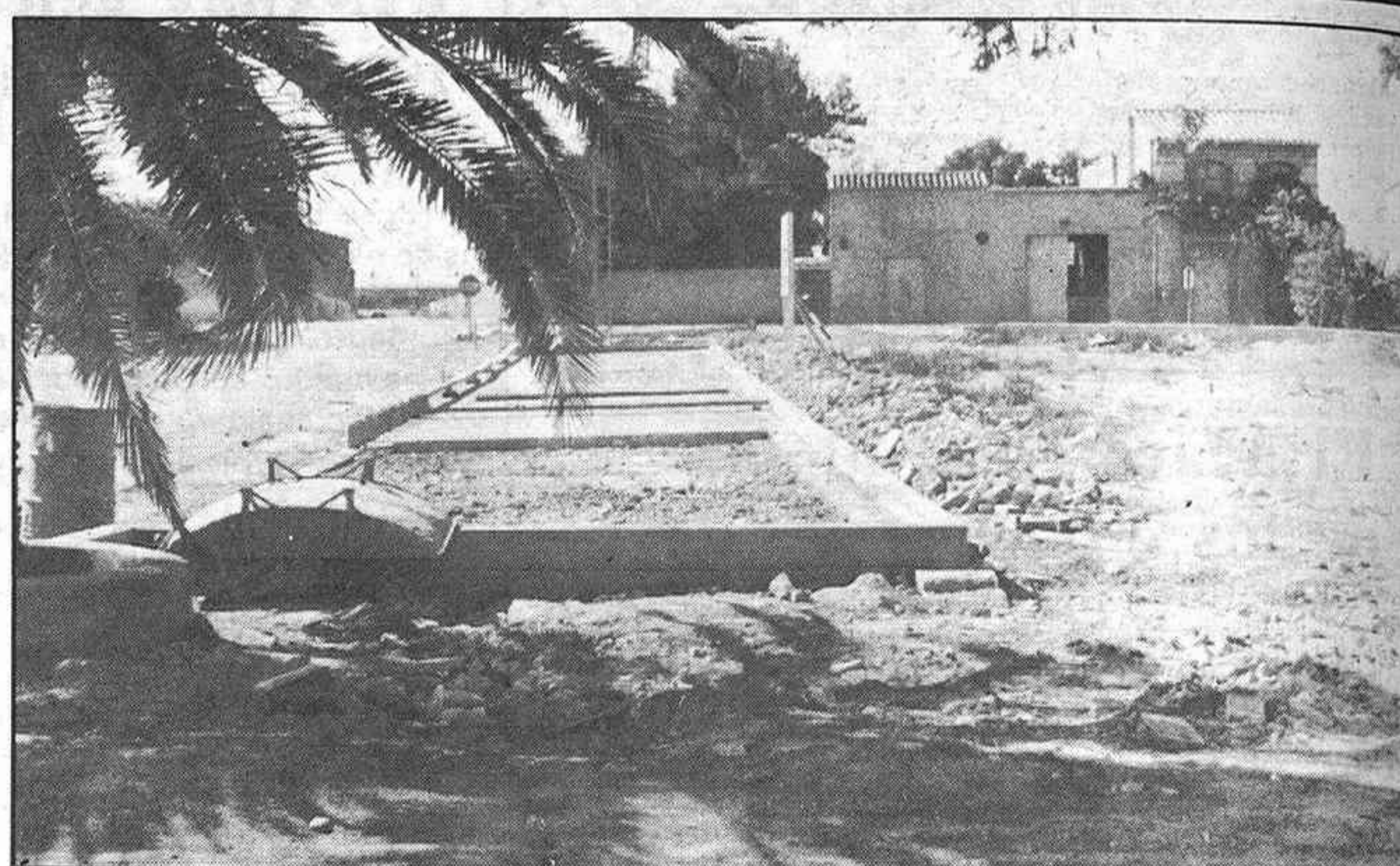
Las obras de remodelación de la parcela prosiguen a buen ritmo (Foto: P. C.)
