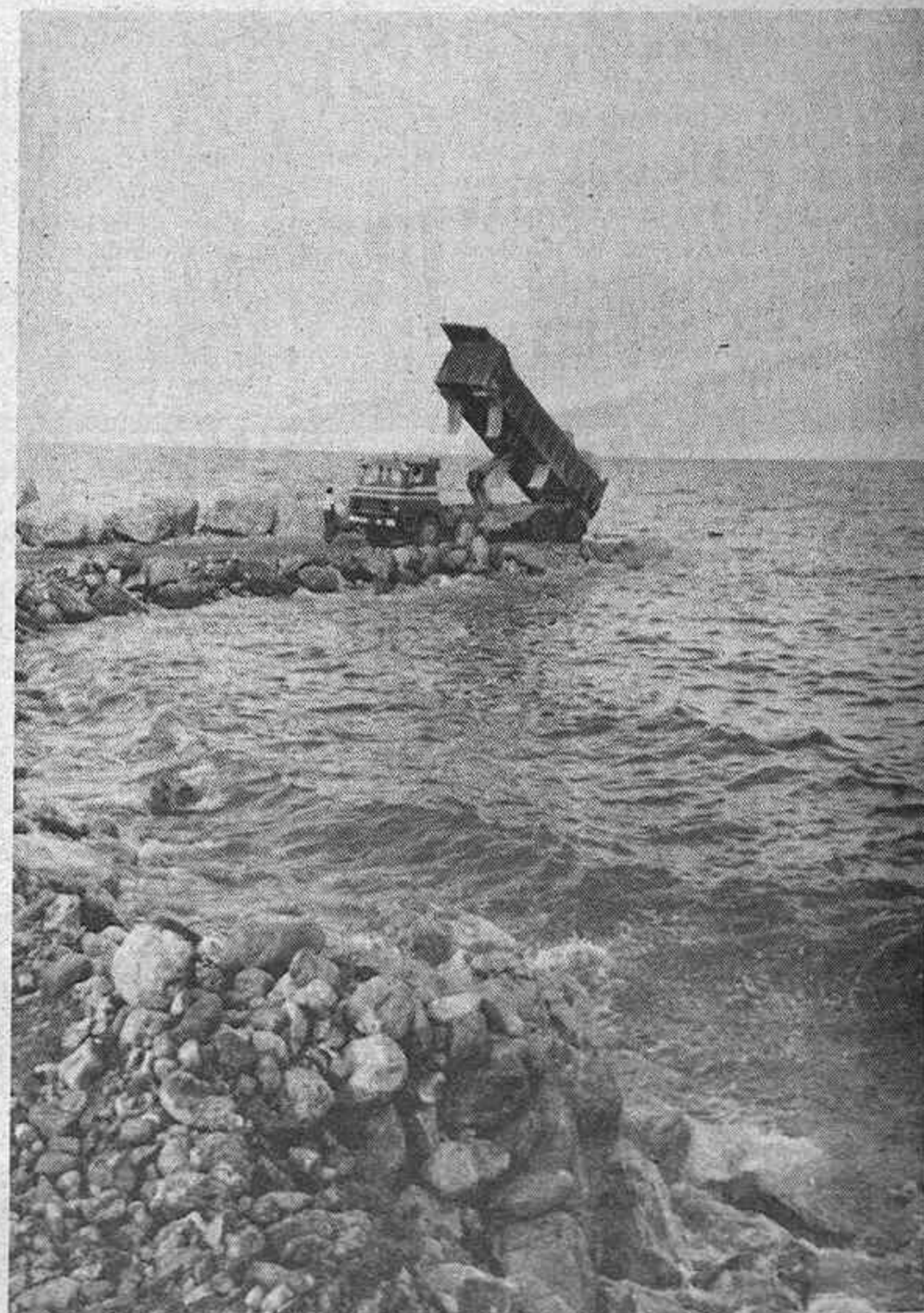
El camión dejó caer al agua la primera piedra de la segunda fase de construcción
