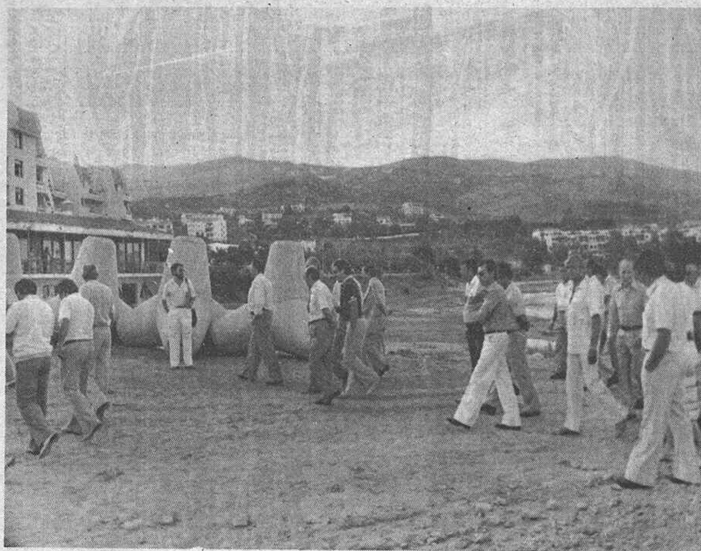
Vista de las obras que configuran la construcción del Puerto Deportivo Las Fuentes
