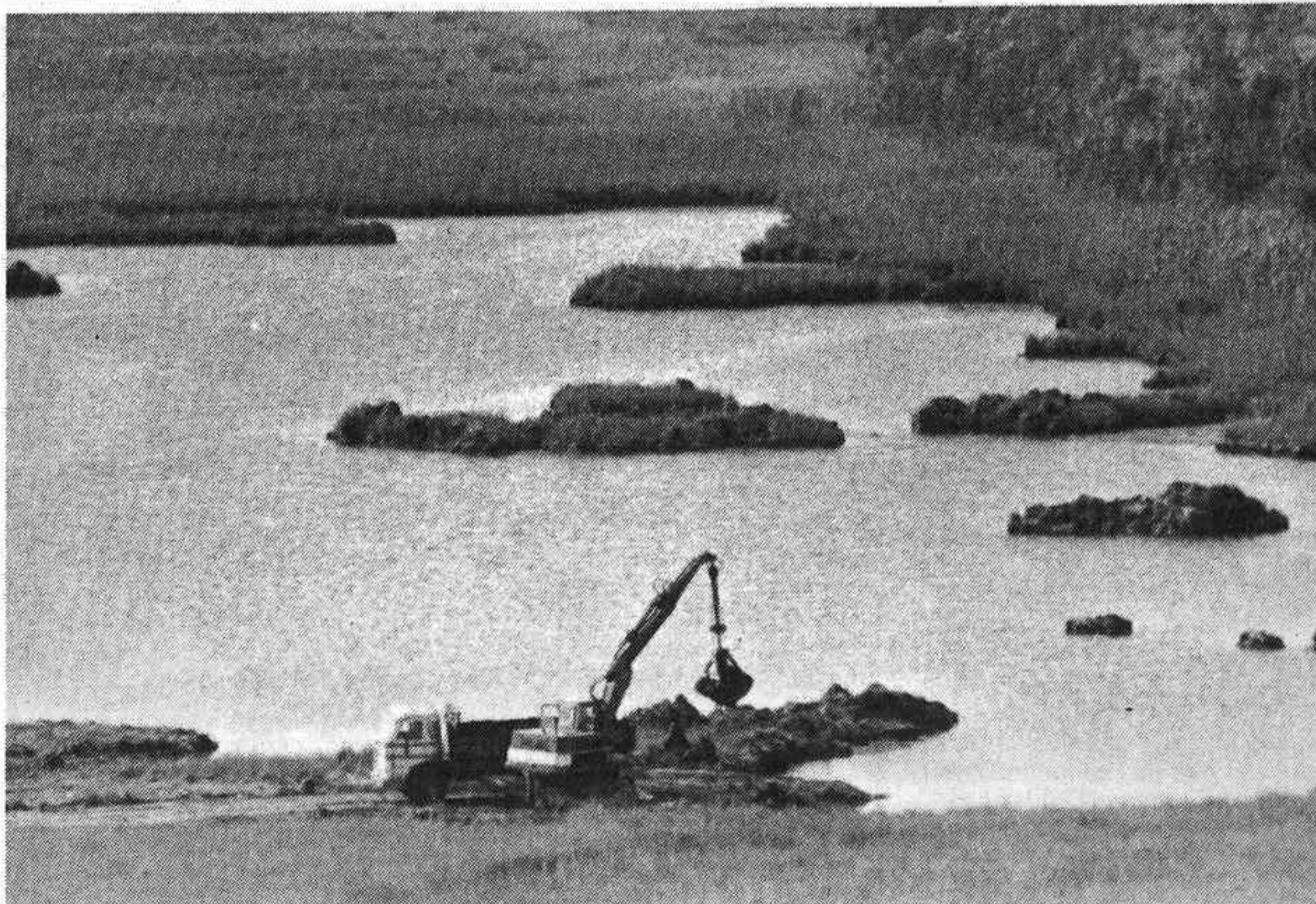
Extracción de turbas en plena explotación en el prado de Torreblanca
