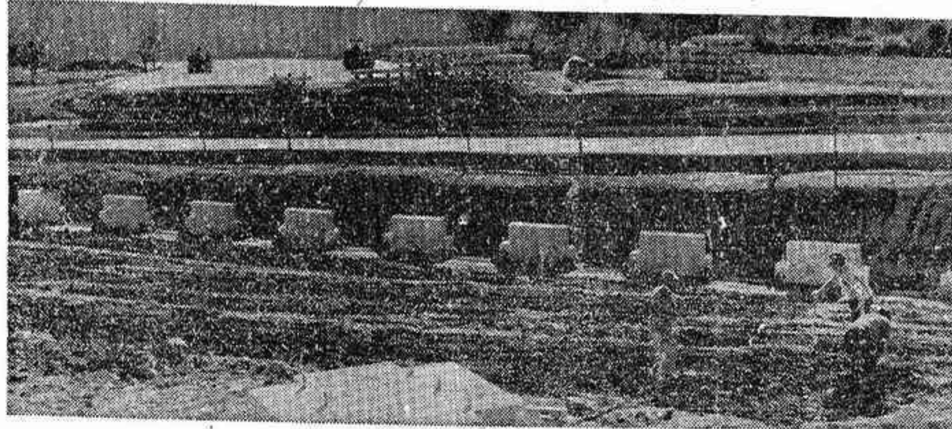
Obras de fábrica en el cruce con la carretera de Altura
