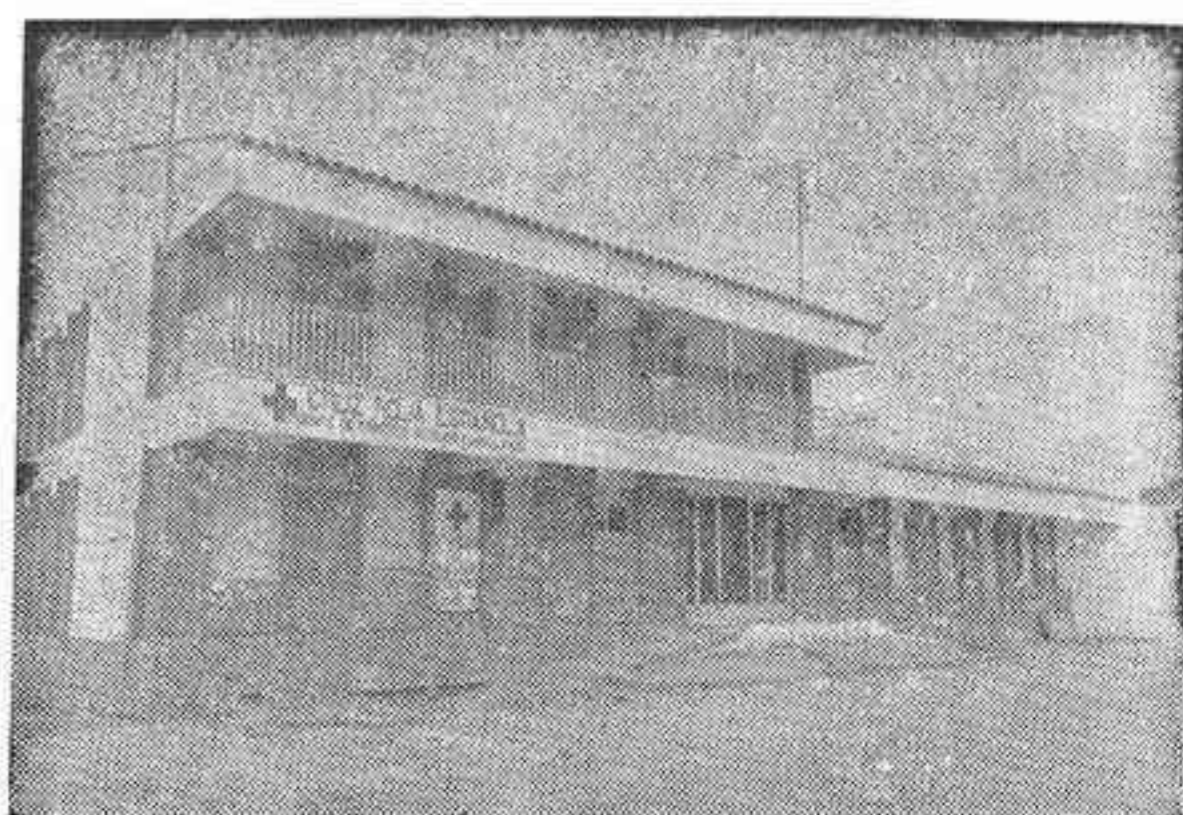
Entre las obras realizadas en el último año destaca el nuevo centro sanitario y puesto de la Cruz Roja, dotado con ambulancia
