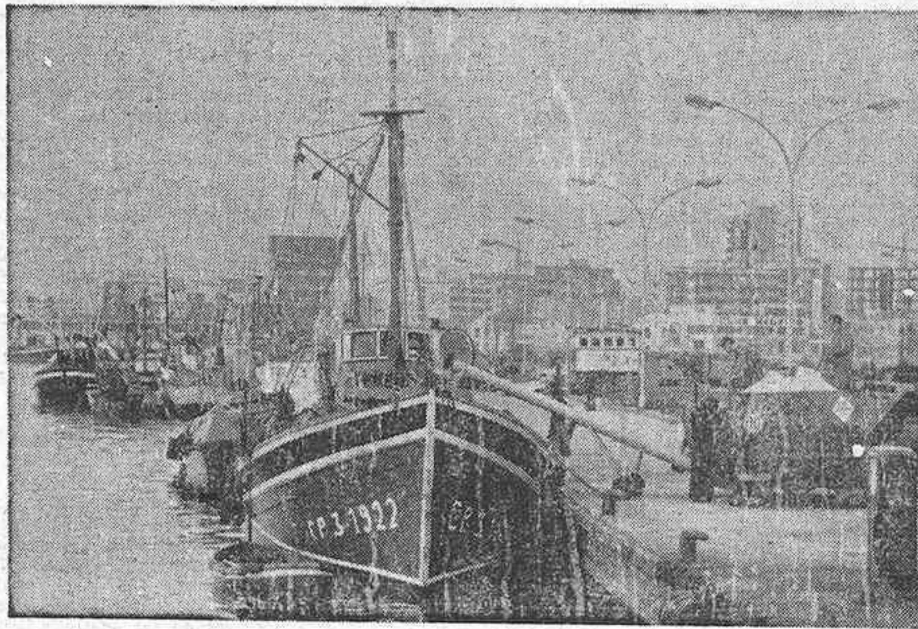
Puerto Pesquero. Falta líneas de atraque para las embarcaciones transeúntes.
