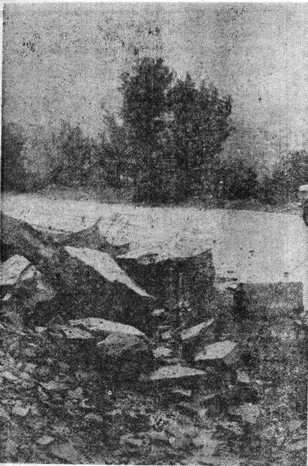
Las lluvias de estos últimos días, han provocado desprendimientos de rocas en la carretera del Desierto de Las Palmas, propiedad de la Diputación Provincial.
