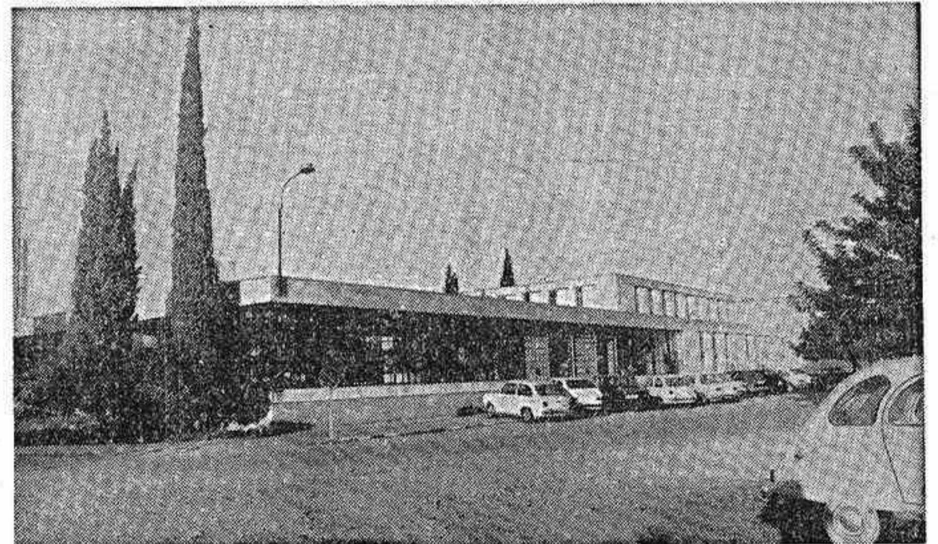
El actual emplazamiento del colegio, en el kilómetro 72 de la carretera nacional 340, a 5 kilómetros del caserío de Castellón. Capacidad: 450 alumnos.
