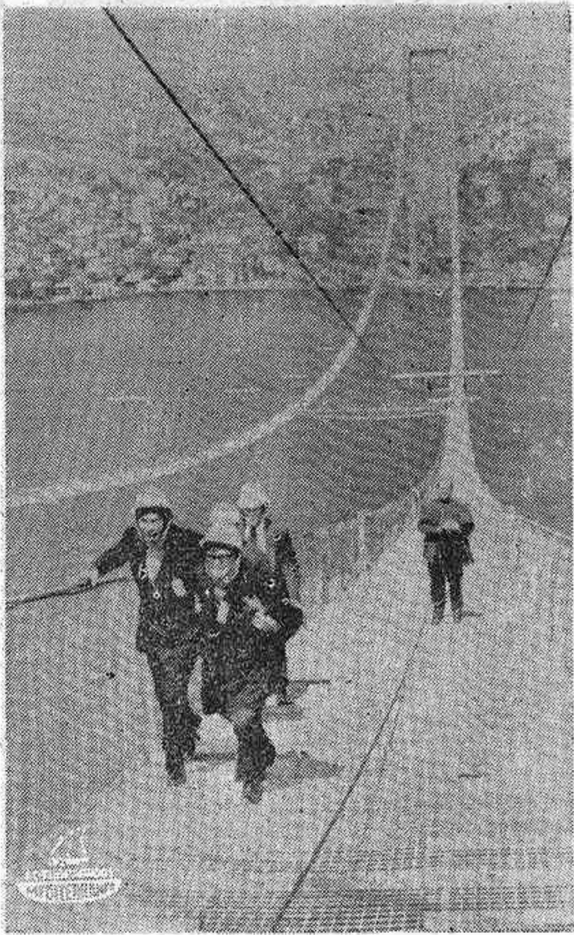
ESTAMBUL. — Un grupo de periodistas atraviesa a pie el Bósforo, sobre un puente. El nuevo puente, primero que unirá Europa con Asia, comenzó a construirse en febrero de 1970 y quedará totalmente terminado en julio de 1973. Mide 1.074 metros de longitud y se espera que sirva para resolver los problemas de tráfico de Estambul. Se trata como puede apreciarse por la presente foto, de un puente colgante. — (Telefoto CIFRA GRAFICA-UPI)
