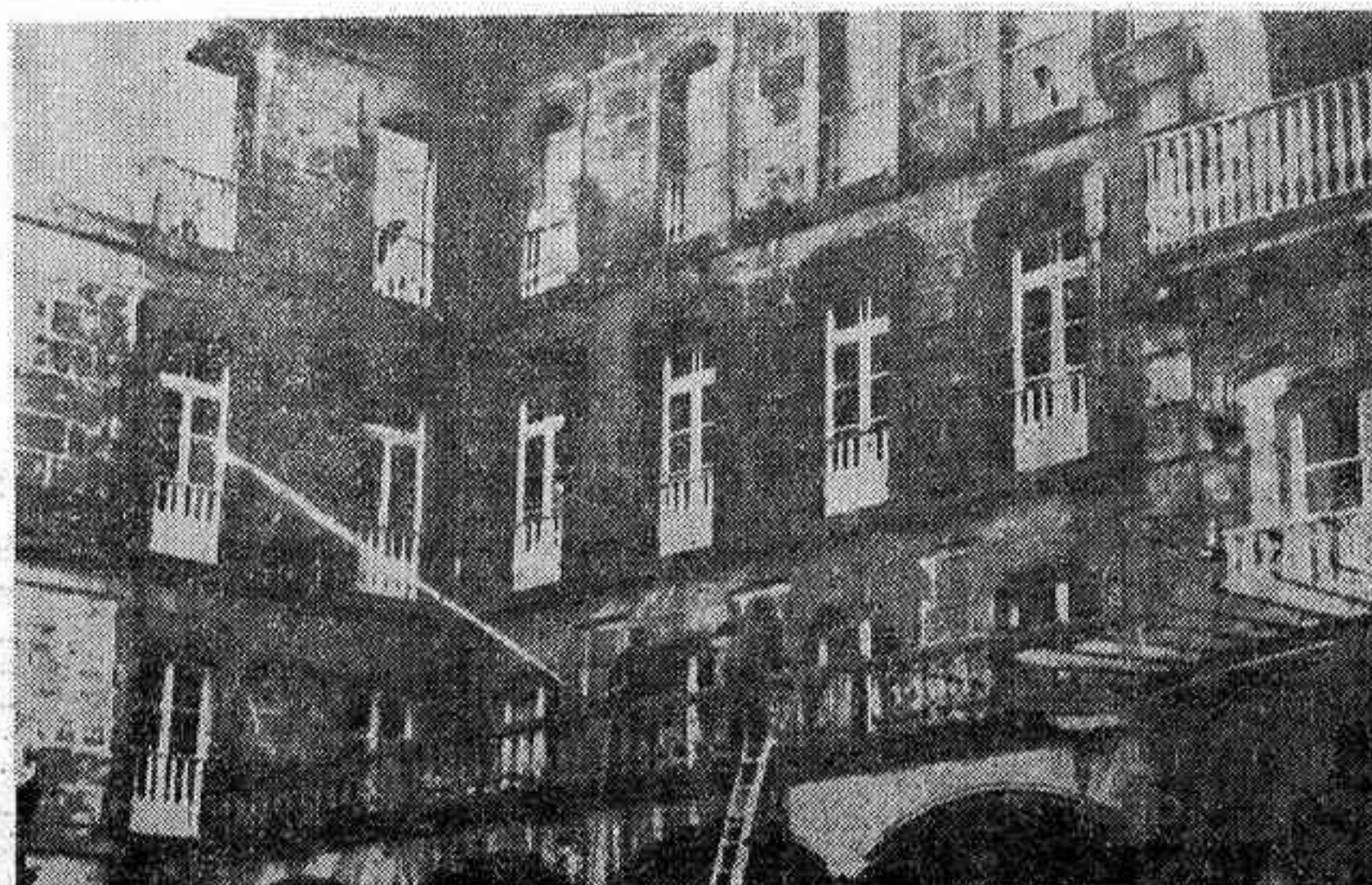
MONDARIZ (Pontevedra).— Se declaró un gran incendio en el hotel balneario de Mondáriz. Si bien los trabajos de los bomberos para sofocar totalmente el siniestro. Del edificio, en la actualidad, tan sólo quedan en pie las paredes maestras. — (Telefoto Cifra Gráfica).
