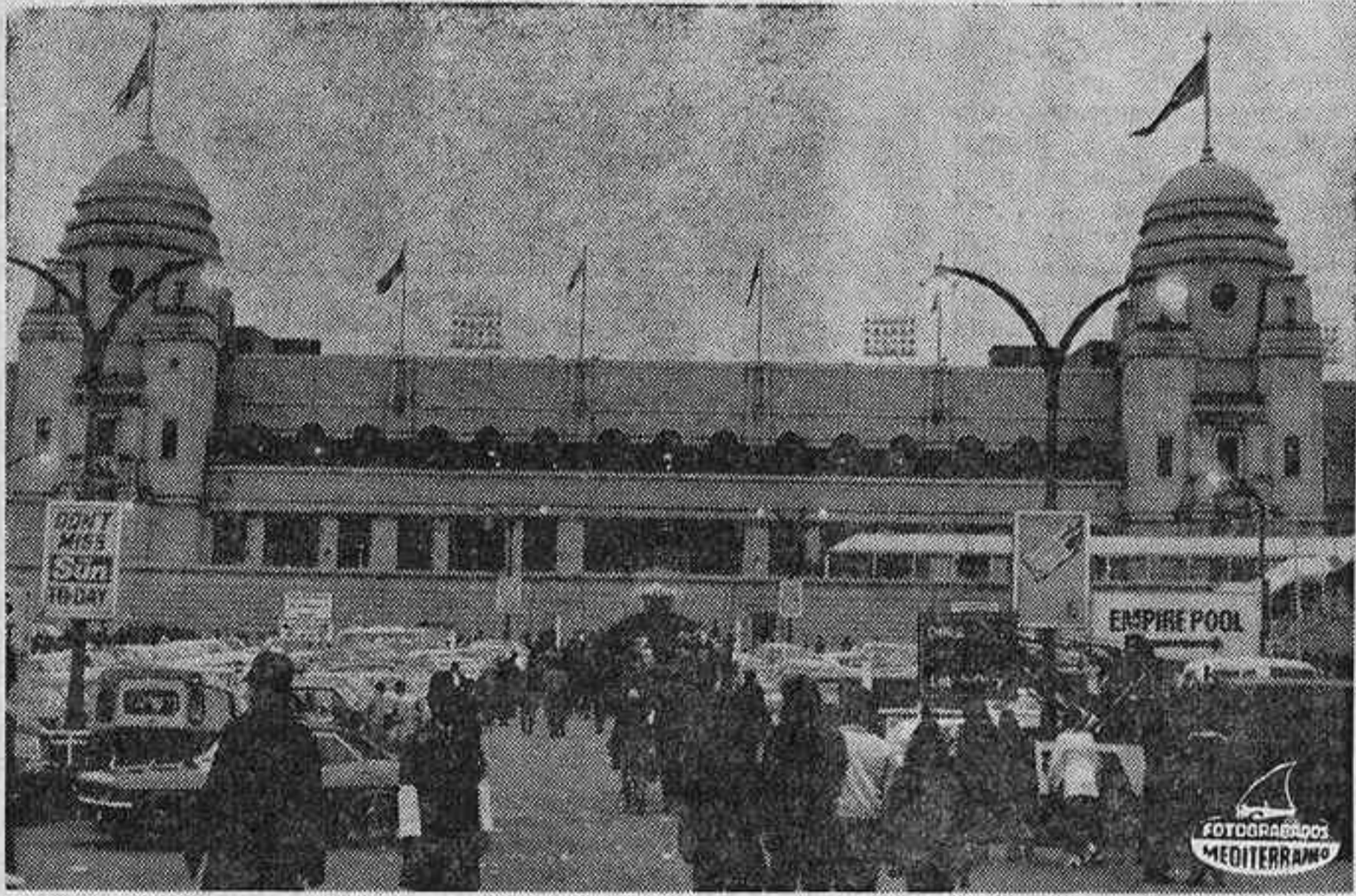
Puerta principal de acceso a Wembley. (Foto PYRESA).
