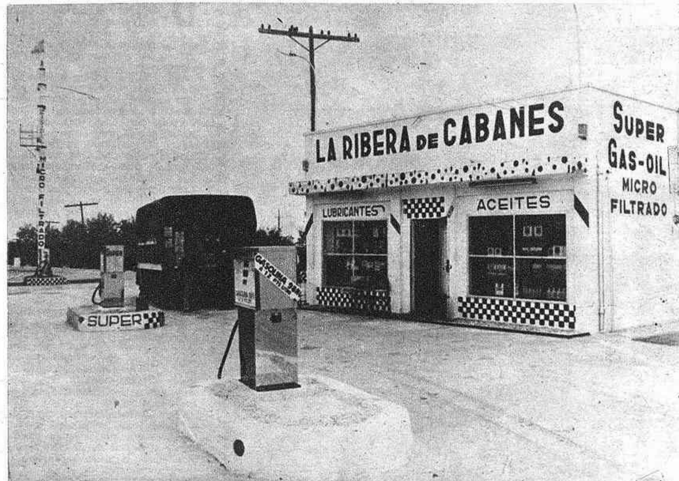
Y un poste de Gasolina Super Extra 98
