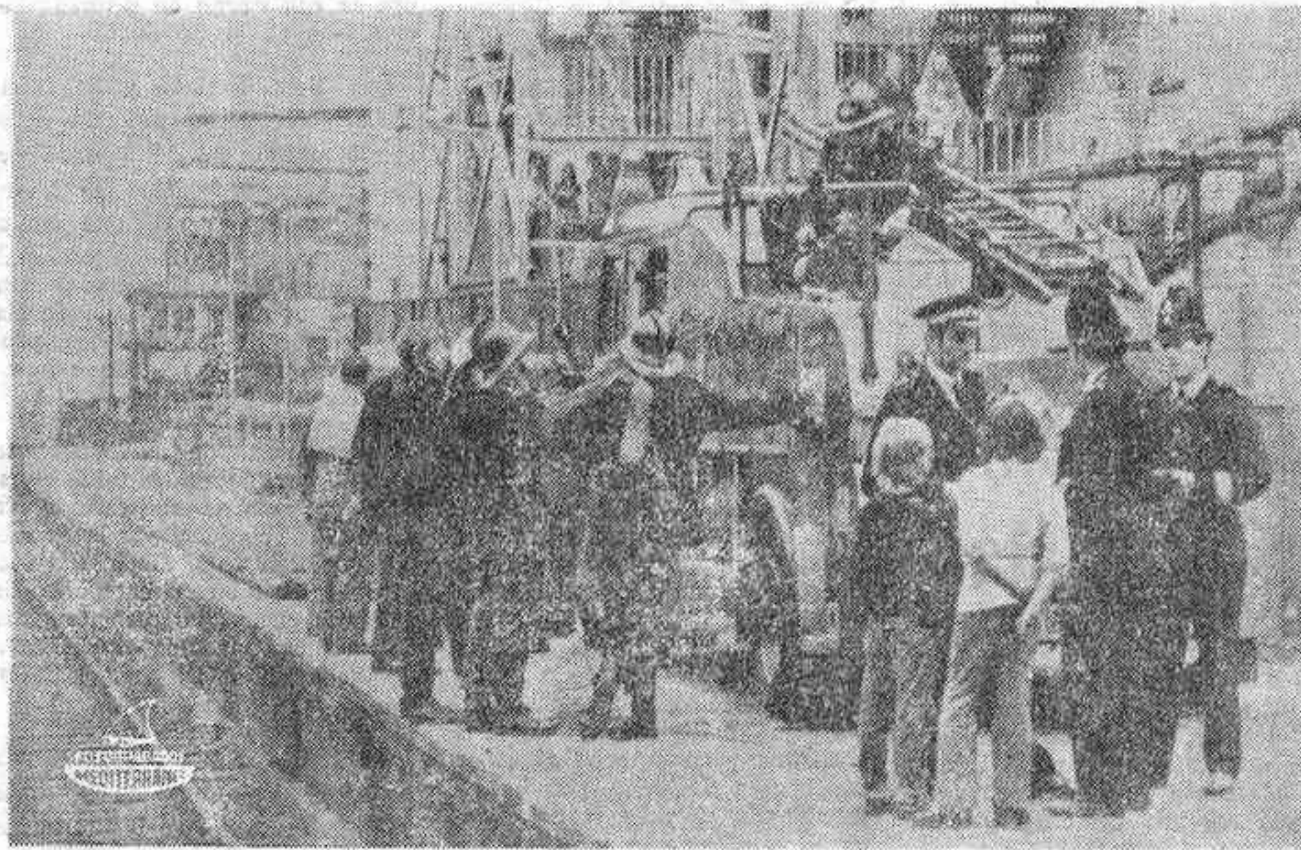
LONDRES.—Policías y bomberos montan guardia en el viaducto de Holborn, después de haber hecho explosión un cilindro de gas, creyéndose que se trata de un nuevo incidente relacionado con la colocación de bombas explosivas e incendiarias en los últimos días, en distintos establecimientos londinenses.—(Telefoto Cifra Gráfica-Upi)
