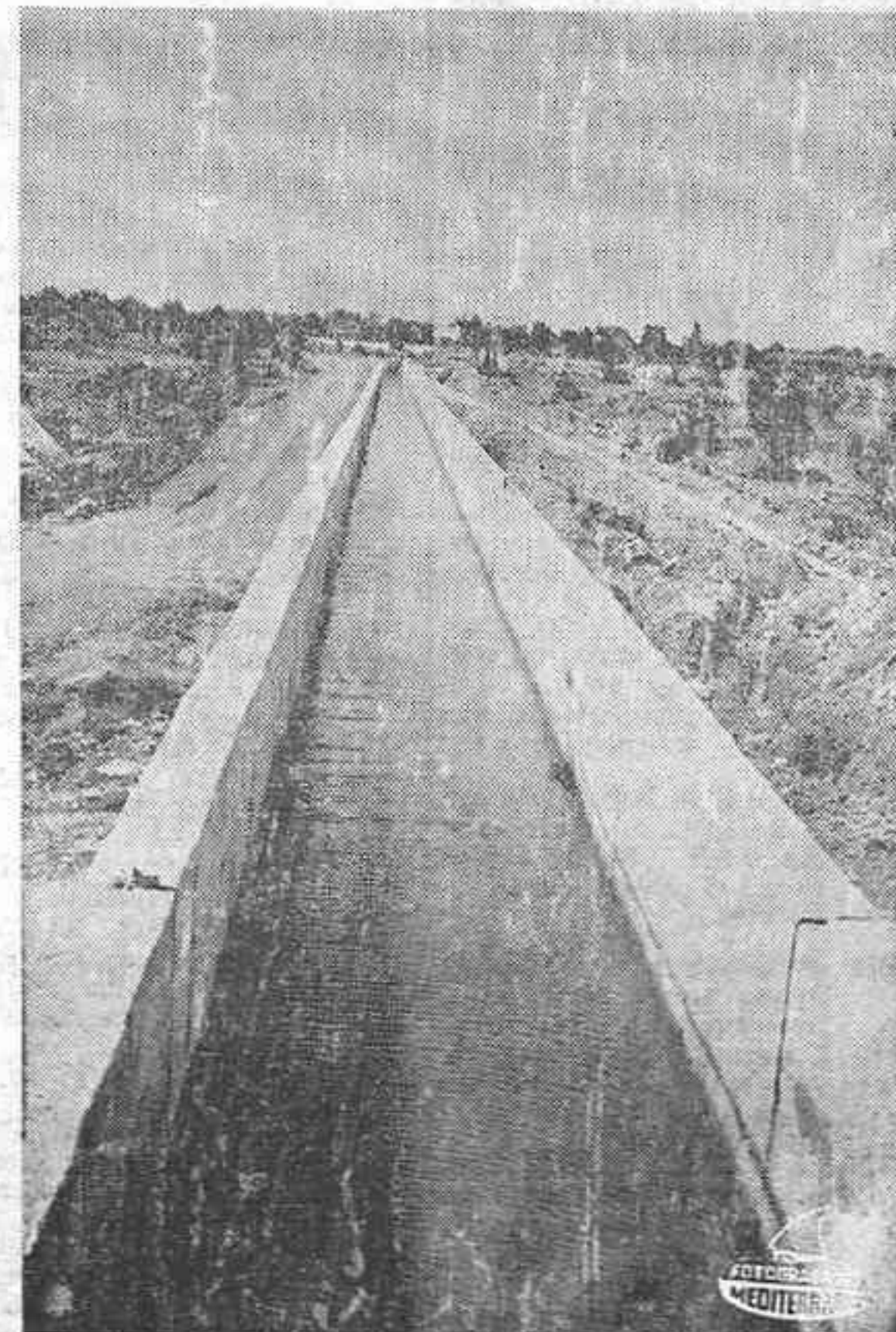
TRAMO DEL CANAL 100
